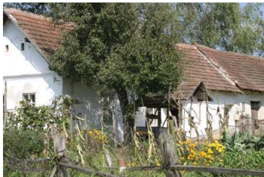
Lakóház Kódisállásos lakóház (Szompács)
